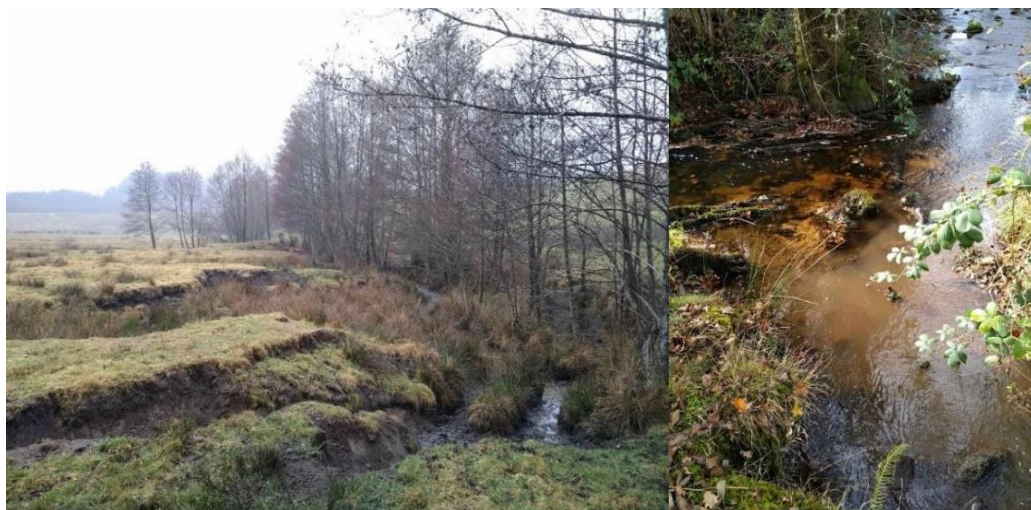
Dégradation des berges et pollution sédimentaire associée sur un affluent de la Combade
